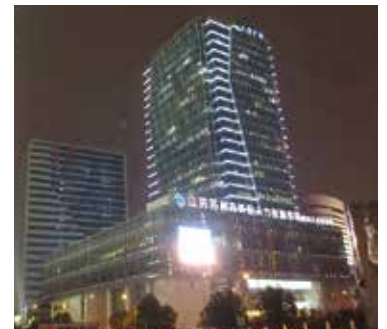
金澤森康商貿(蘇州)有限公司の入居ビル
